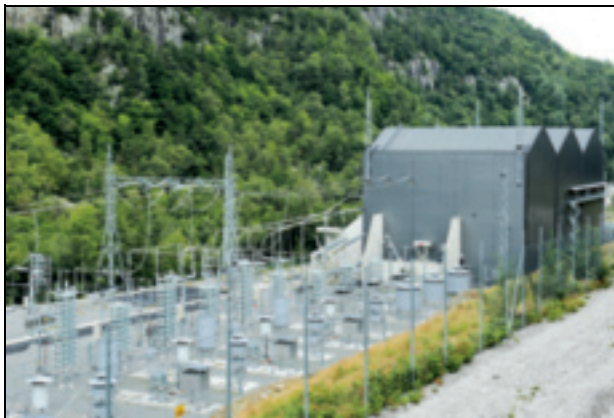
Figur 3.11 Likeretteranlegg i forbindelse med NorNed kablen mellom Norge og Nederland
