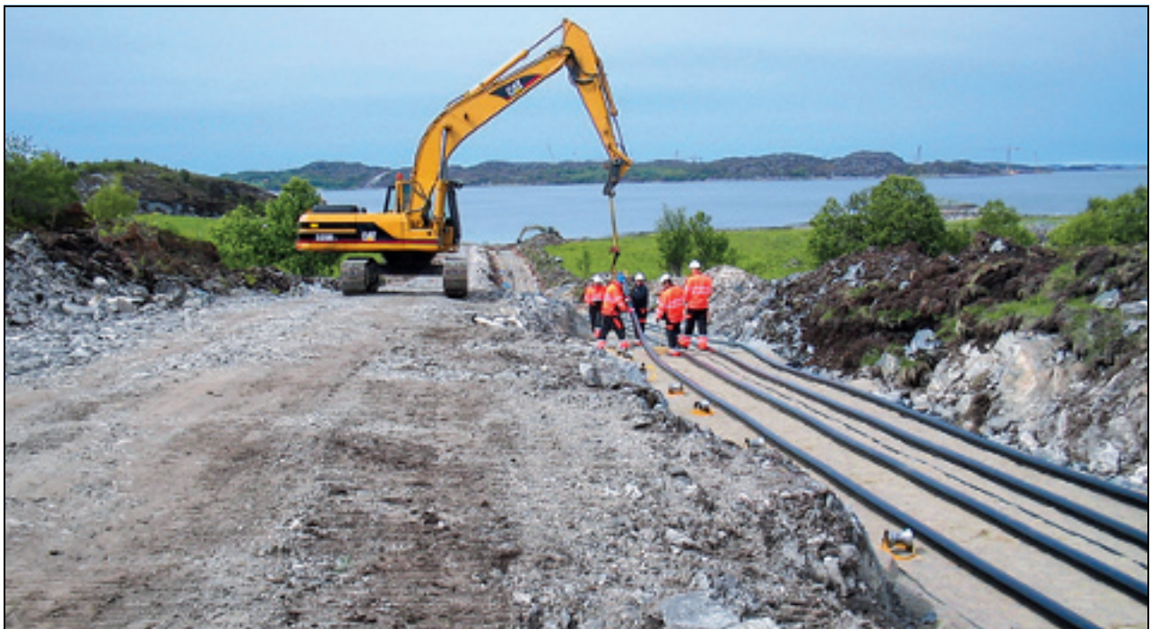
Figur 6.13 Legging av jordkabel på 420 kV (4 kabler) i forbindelse med Ormen Lange
